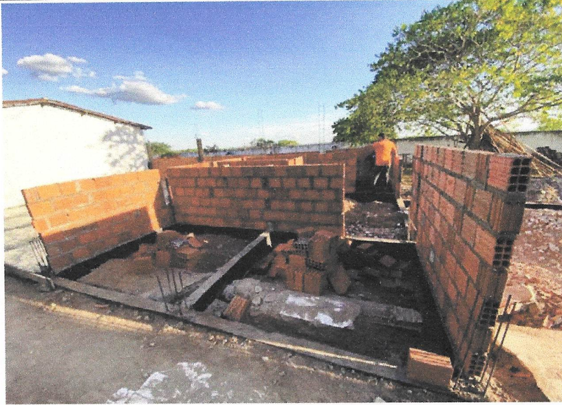
LEVANTE DE ALVENARIA E MONTAGEM DOS PILARES
