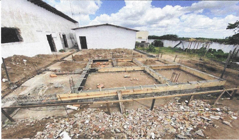
IMPERMEABILIZAÇÃO DAS VIGAS BALDRAME
