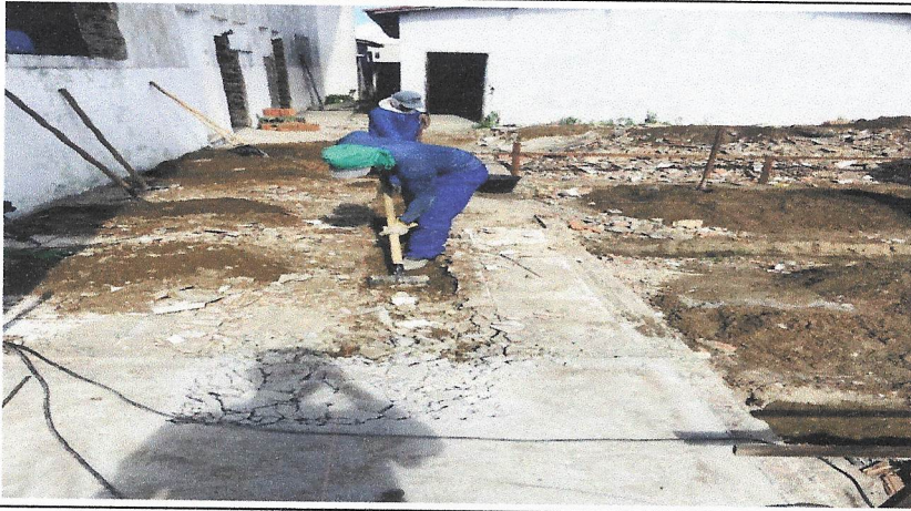
DEMOLIÇÃO DE RESERVATORIO
