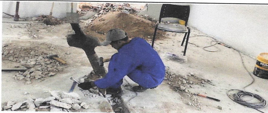
DEMOLIÇÃO DE PISO PARA ESCAVAÇÃO DE FUNDAÇÃO
