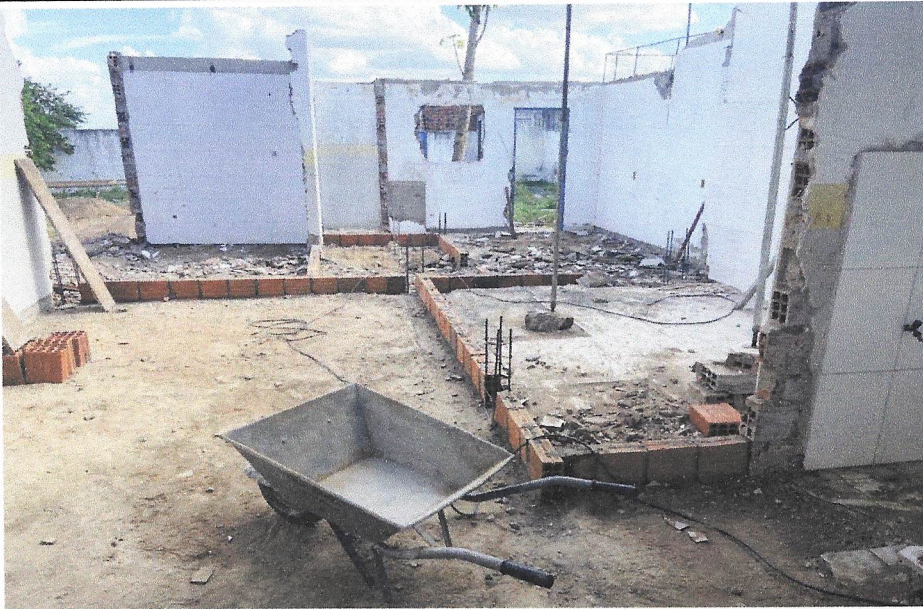
MARCAÇÃO DE ALVENARIA
