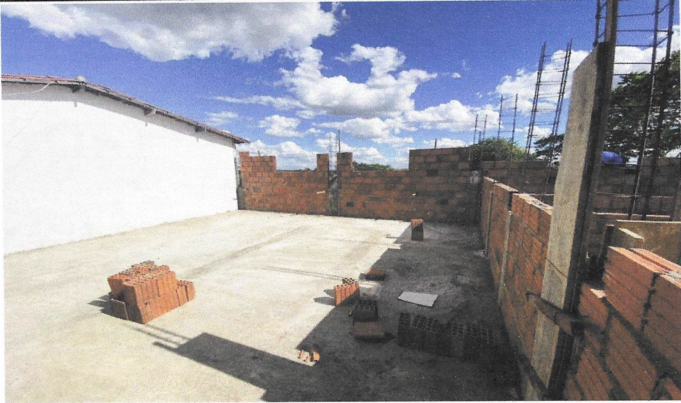
PISO DE CONCRETO E LEVANTE DE ALVENARIA
