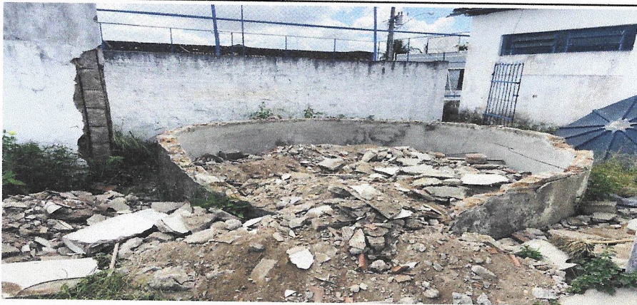
DEMOLIÇÃO DE PISO
