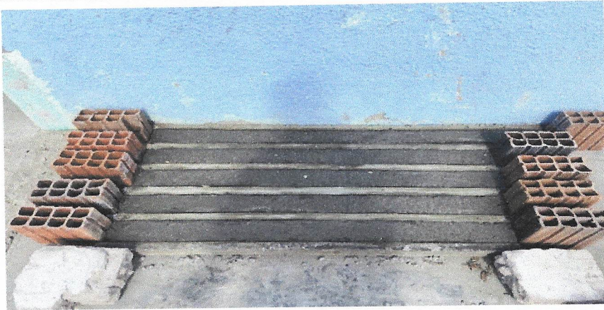
CONCRETAGEM DE VERGAS E CONTRA VERGAS
