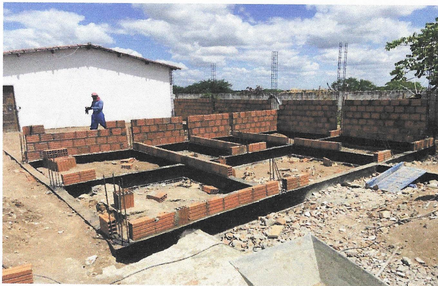
LEVANTE DE ALVENARIA
