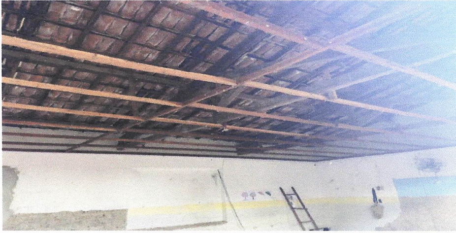
LEVANTE DE ALVENARIA
