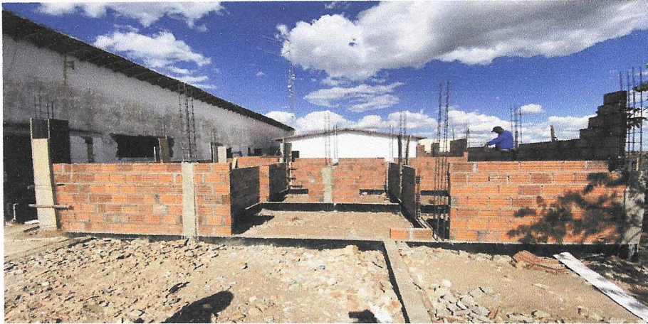
LEVANTE DE ALVENARIA
