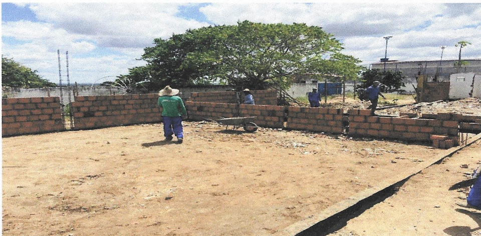
ATERRO E COMPACTAÇÃO
