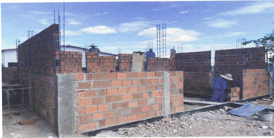
LEVANTE DE ALVENARIA
